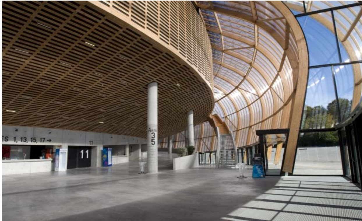
Le foyer – vu depuis le hall d’entrée publique – parement bois acoustique en plafond
