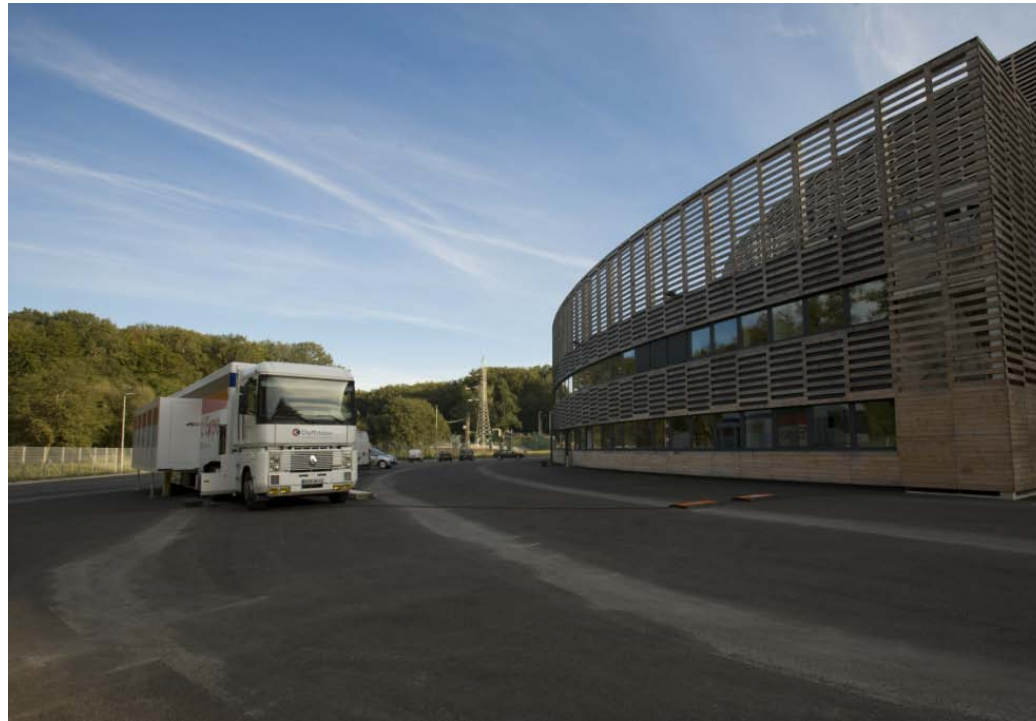
La façade arrière – back stage – parement bois des façades
